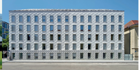
Die Zentrale: Neubau des Landeskirchenamtes
